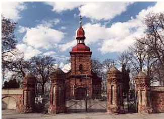
Kościół pw. św. Andrzeja w Przemęcie – stan obecny.
